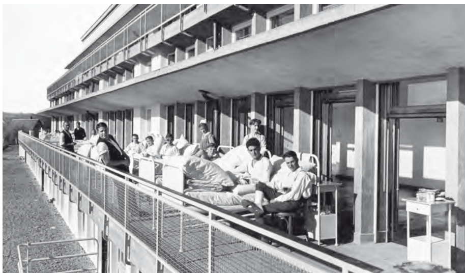
Abb. 1: Bezirkskrankenhaus Waiblingen 1928; Quelle: Deutsches Architekturmuseum Frankfurt . Das 1927/1928 von Richard Döcker als Terrassentyp erstmals in Stahlskelettbauweise errichtete Krankenhaus folgte der medizinischen Literatur jener Zeit, welche auf die wichtigen Heilfaktoren von „Licht, Luft und Sonne“ verwies.
