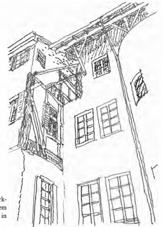
Rathausgasse 1 – mittelalterlicher Fachwerkbau mit späterer Aufstockung und neuem Anbau; das alte Fachwerk wurde nur in Fragmenten freigelegt.
