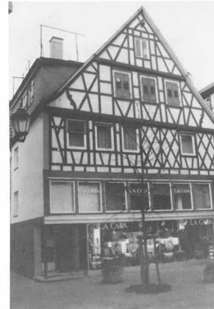
Abb. 1.2 Neues Bauen nach alten Maßstäben? Neubau 1965: Das Bretterfachwerk ist eine Art Rekonstruktion
