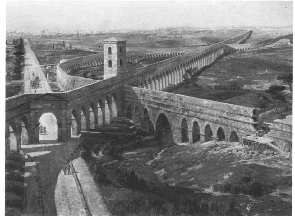
Abb. 6: Antike Wasserleitungen nach Rom (Gemälde von Zino Diemer, 1913, Deutsches Museum München). Links die nach Rom führende Via Latina. Von links nach rechts laufend der Doppelaquädukt Aqua Claudia / Aqua Anio Novus, darunter von rechts kommend der Dreifachaquädukt Aqua Marcia / Aqua Tepula / Aqua Iulia.
