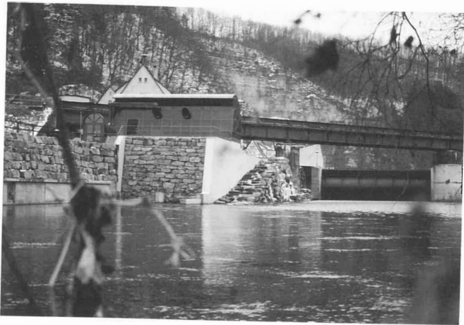
Abb. 2.: Rottenburg/Neckar: Wasserkraftwerk »am Preußischen« mit Krafthaus, Brücke, Klappe und Fischtreppe.
