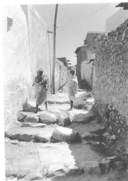
Abb. 12: Typische Gasse mit felsigem Grund in der Altstadt, 1987. Rechts durch Abwasser vom Hofinneren aufgeweichte Erdmörtelmauer (Foto: F. Stuber).
