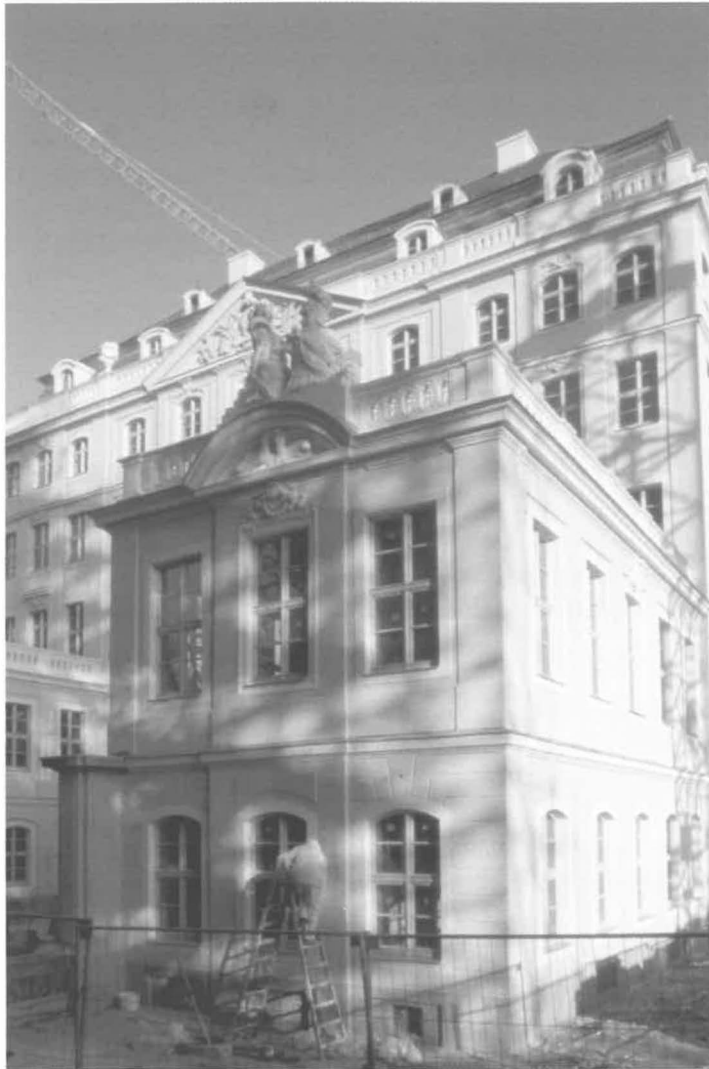
Abb. 2: Das neu auf- gebaute, rekonstru- ierte Coselpalais.
