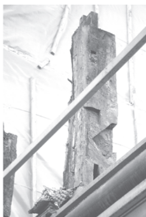
Abb. 6: Das Haus Kurze Geismarstraße 30 im Oktober 2004. Rechts einer der während des Abrisses sichtbaren Fassadenständer mit seitlichen Ausnehmungen für Kopfband und Brustriegel. Auf der Vorderseite ist im oberen Bereich am helleren Holz der Rest der abgesägten Knappe zu erkennen.
