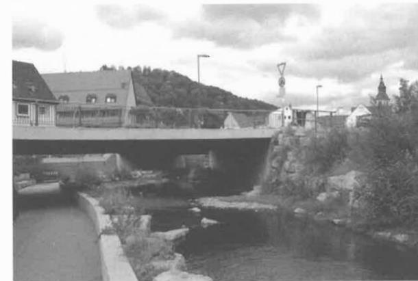
Abb. 2: Geöffnete Waldach, früher unter Betondeckel.
