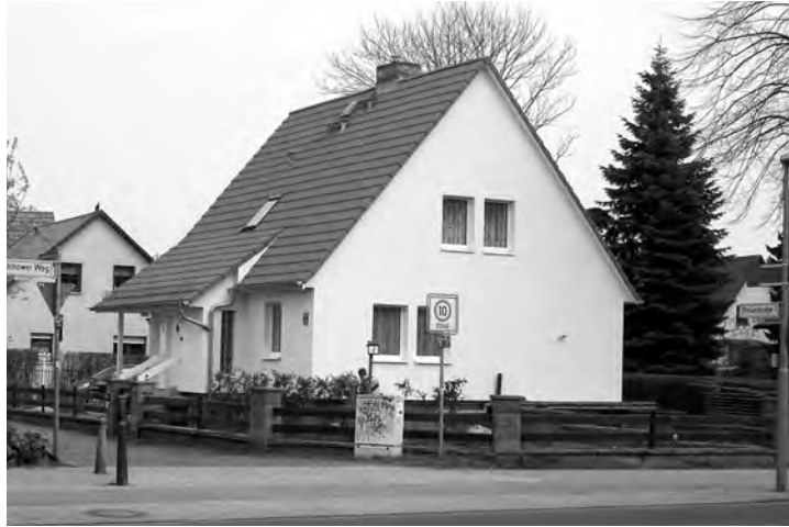
Abb. 8: Einzelhaus FH 89/79 saniert (2009).
