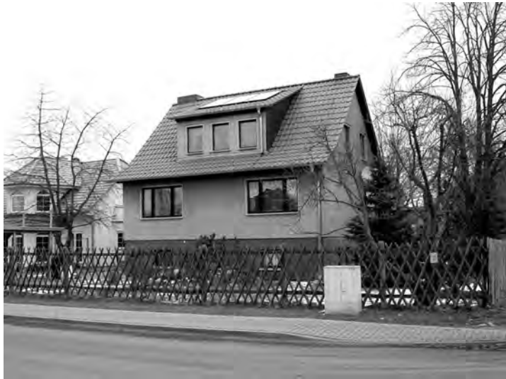
Abb. 4: Einzelhaus EW 65 B/ teilmodernisiert.
