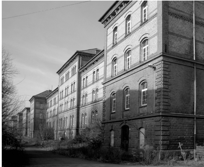
Abb. 16 b: Kasernengebäude Estienne-Foch.
