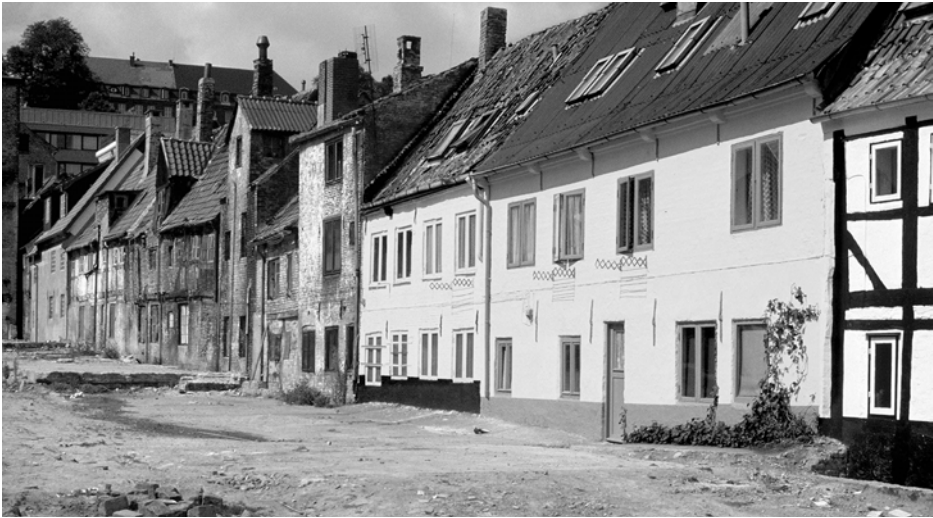
Abb. 8: Flensburg, Oluf-Samson-Gang, Südseite der unsanierten südlichen Häuserzeile nach Freilegung um 1982 (Foto: Uwe Gorzolla).
