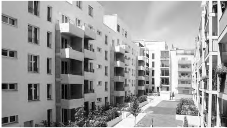
Abb. 4,5: Frankfurt a.M.: innerstädtisches Passivhausprojekt „Campo“.
