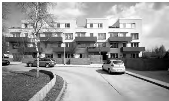
Abb. 1 a, b: Leinefelde, Umbau des Plattenbaus Goethestraße.
