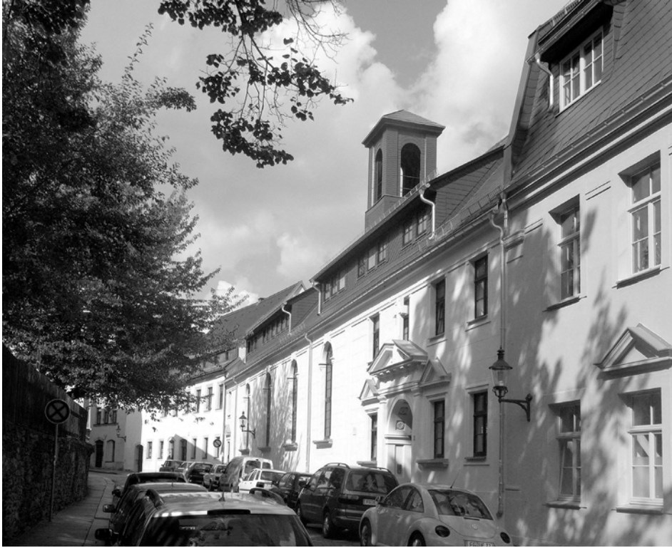
Abb. 8: Ehemalige katholische Kirche, jetzt Wohngebäude, bedacht mit dem „Freiberger Sanierungspreis 2010“; Foto: Rainer Bruha, September 2010.
