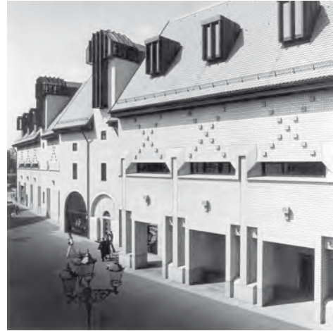
Abb. 9: Kaufhausfassade zum Neuen Markt; Aufnahme: K. Kienold, München, um 1978; Quelle: saai , Fondation Heinz Mohl (s. A 1).
