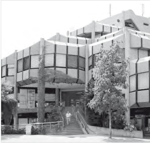
Abb. 25: Treppensituation Marktdreieck vor der Sanierung; Foto: H. Schultheiß, 2004
