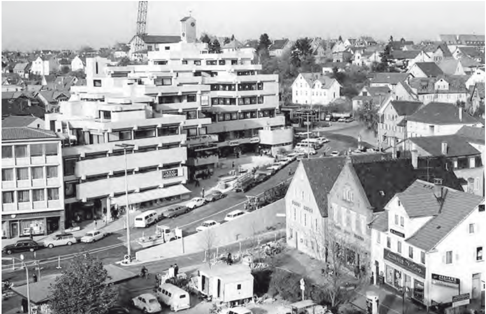
Abb. 17: »Querspange« am Alten Postplatz, 1969, kurz vor der Fertigstellung; davor der bereits vierspurig angelegte Auftakt der geplanten »Vermittlerstrecke« entlang der Altstadt; deutlich erkennbar ist die entstandene ungünstige städtebauliche Situation am Altstadteingang entlang der Stützmauer für die Straße; am linken Bildrand das Gebäude der Kreissparkasse aus dem Jahr 1955; das Foto wurde auch in der Waiblinger Kreiszeitung veröffentlicht mit der Bemerkung: »Die Querspange – neuer großstädtischer Blickpunkt in Waiblingen«; Foto: Stadtarchiv Waiblingen .
