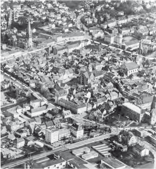
Abb. 1: Luftbild der Altstadt von Ettlingen vor der Sanierung, Aufnahme: H. Schlesiger , Karlsruhe, um 1970; Quelle: saai , Fondation Heinz Mohl (s. A 1).
