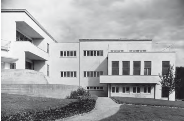
Abb. 11: Bezirkskrankenhaus Waiblingen, 1928: Schwesternbau und Tagraumbalkone; Quelle: Deutsches Architekturmuseum Frankfurt a.M.
