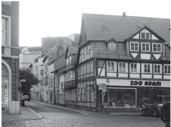
Abb. 12: Braunschweig, Ölschlägern mit „Horten“-Gebäude im Bildhintergrund; Foto: R. Hillmann, 2010.
