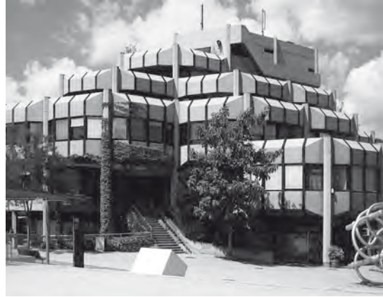
Abb. 2: Marktdreieck in Waiblingen, Aufnahme 2007; aus: C. Wiertlewski (s. A 43), S. 84.
